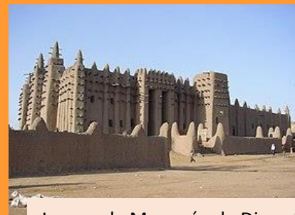
La grande Mosquée de Djenné bâtie en terre crue
